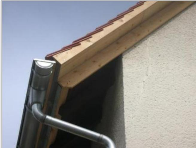
Die **Dachüberstände** sollen nach Eingriffen wieder das gleiche Erscheinungsbild wie im historischen Zustand haben. Das gilt insbesondere auch bei außen aufgebrachtener Wärmedämmung. Für neu herzustellende Dachränder ist der Dachüberstand am Ortgang in einfacher Form mit Ortgangbrett in einer Breite bis zu 40 cm auszuführen. Der Ortgang soll bei Flachziegeln mit Zahnleiste ausgeführt werden. Alternativ sind Ortgangziegel möglich.
