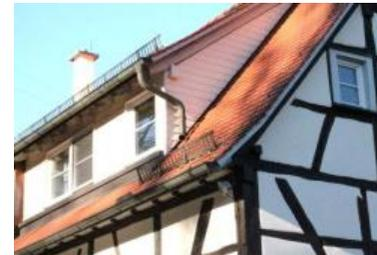
*Satteldach mit Schleppgaube, Zahnleiste am Ortgang*
